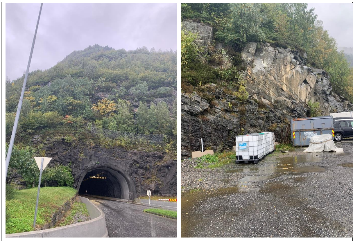
Foto 5: Tunnelinngang til tunnelarm til Rotsethorntunnelen. Før tunnelen ble etablert ble det gjort et stort arbeid med å fjerne urmasser i området, noe som tyder på at området har tidligere vært utsatt for steinsprang.
