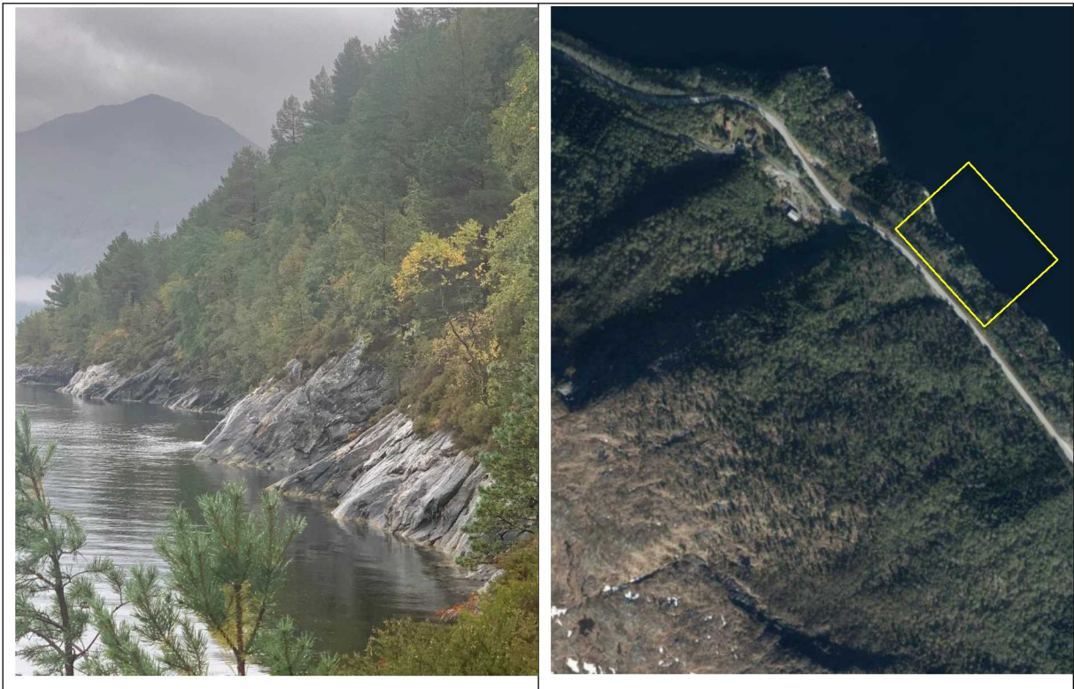
Foto 1: Planlagt tunnelinnslag like over vannflaten i fast berg (venstre). Området over planlagt tunnelinnslag er dekket av tett skog (høyre).
