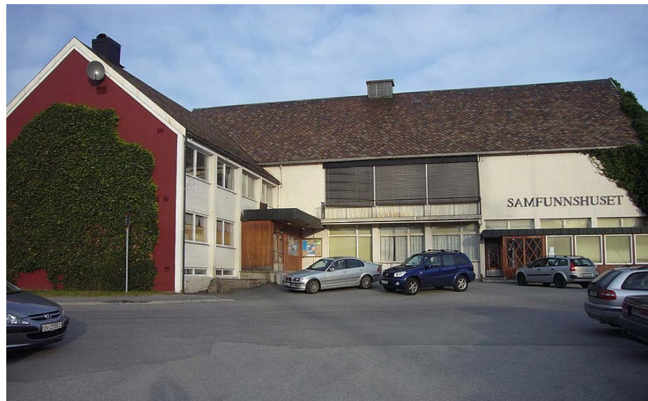
Volda samfunnshus bygd i 1955, foto: Volda kommune
