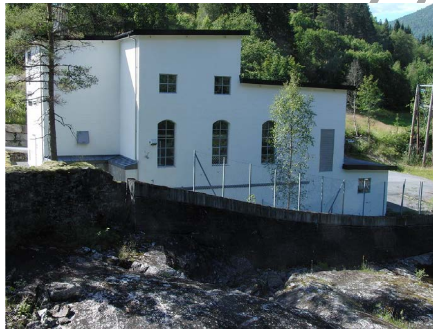
Kolfossen kraftverk, foto: Wikipedia
