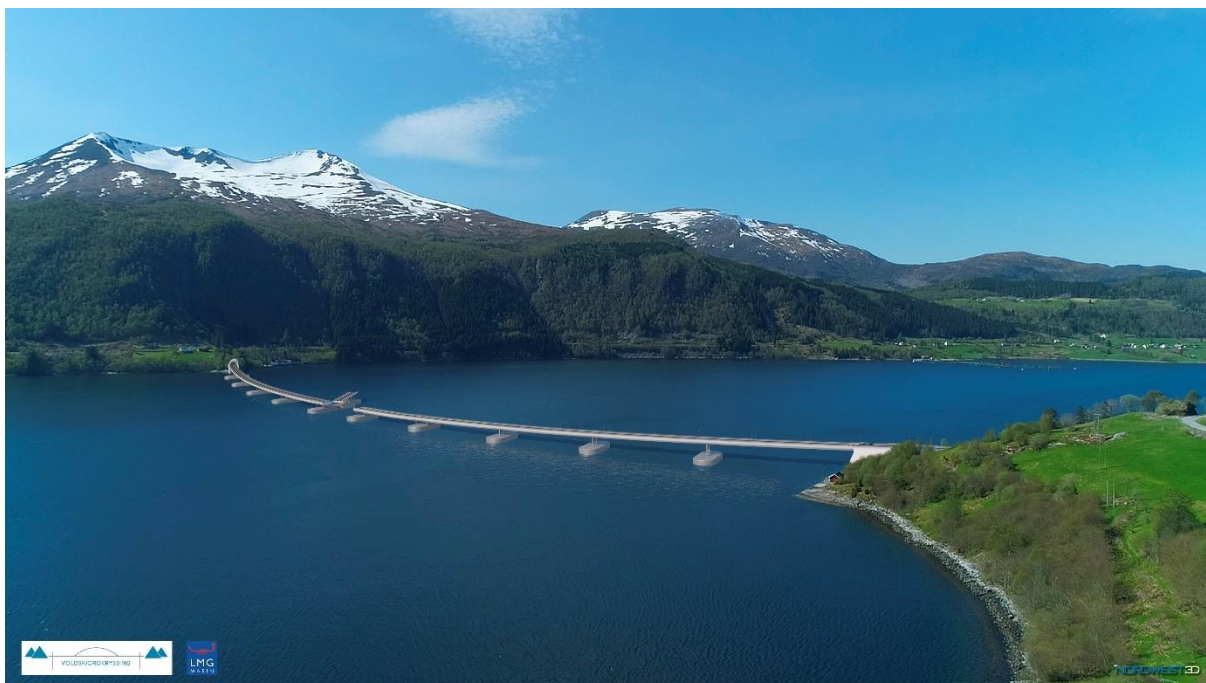
Figur 5-1: Mogleg løysing med flytebru over Dalsfjorden : (Illustrasjon: LMG Marine).
