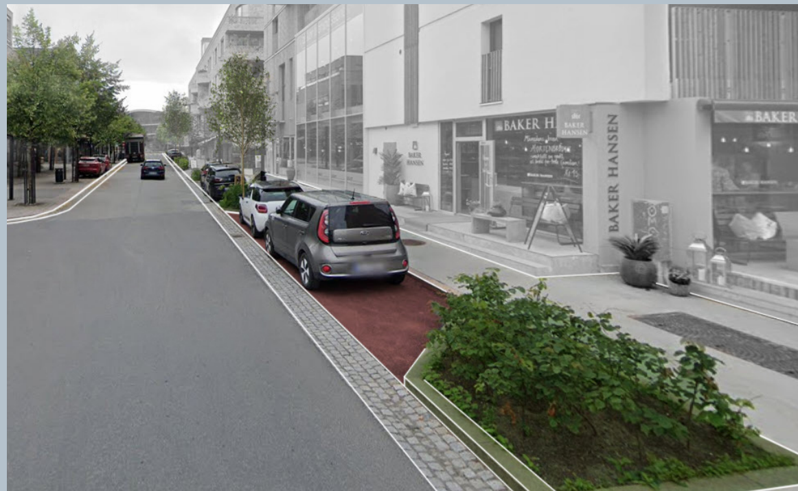
Bankveien i Asker. Gate med grønt preg og gateparkering i lommer, der vegetasjon og trær gir et trivelig bymiljø. Samtidig er parkering begrenset og tydelig avgrenset, noe som gir bedre plass og trygghet for myke trafikanter. Illustrasjon: Google Street View/ Multiconsult
