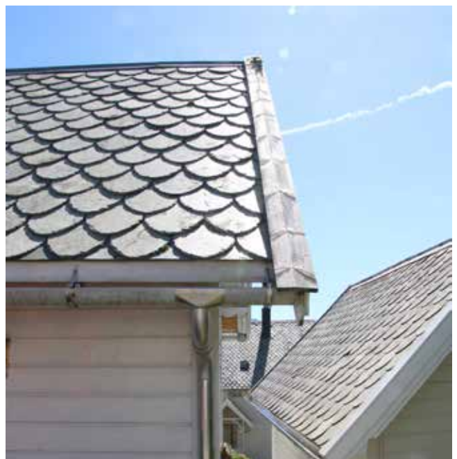
Skifertak i Volda sentrum. Foto: Regine S. Aklestad.
