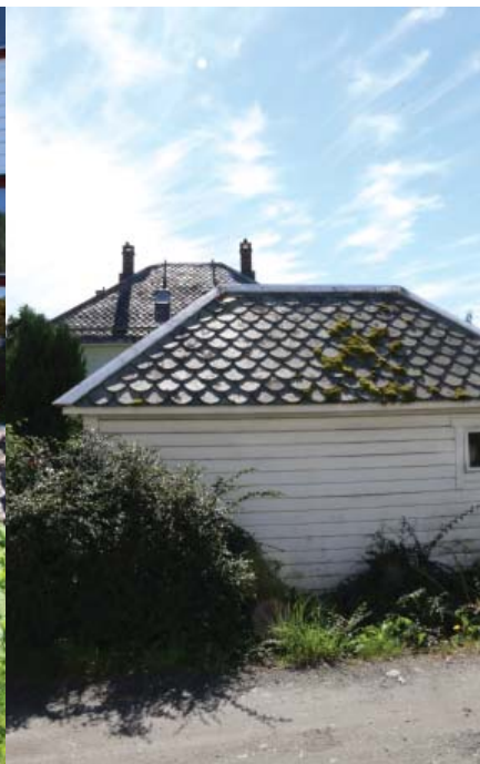
Tak på uthus står i stil med hovudhuset.
