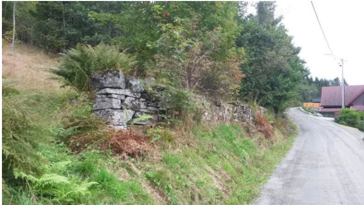
Foto av Steingard i området
