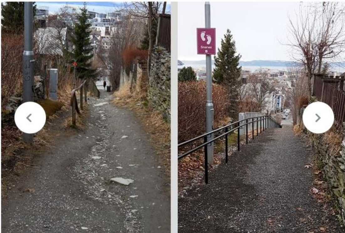
Før og etter oppgradering. Referanseprosjekt i Trondheim. Foto: Miljøpakken Trondheim.
