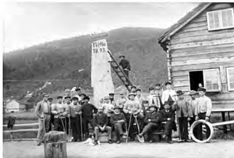
Den fyrste inntaksstolpen til telefonstasjonen på Grodås.
