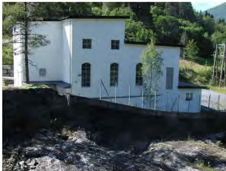
Kolfossen kraftverk, foto: Wikipedia.
