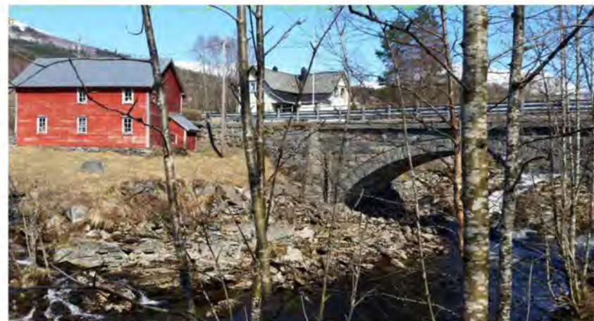
Gamle Rødemel bro under, det raude huset er Mølla. Foto: H.H. Holmøy- Wang.
