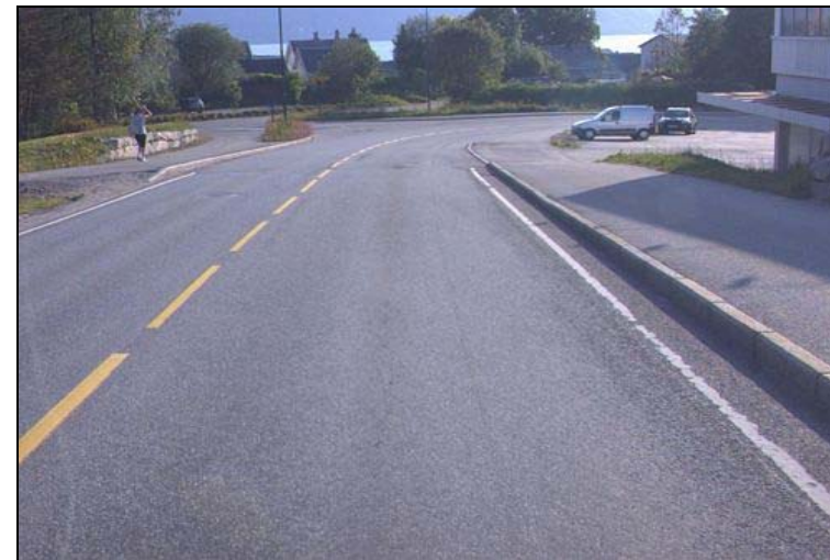
Krysset Elvegata x Ristevegen. Fortau på nordsida av vegen, samt fortau frå busslomma på sørsida av vegen.
