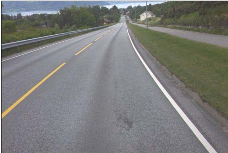
Sett vestover. Vikebygdvegen (fv 45) med eksisterande g/s-veg på nordsida av vegen. Lite og spredt bebyggelse, opent og oversiktleg, i nærleiken av Bakkelidvegen.
