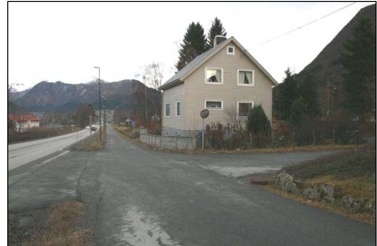
Avkøyrse ut i E39 som kryssar g/s-vegen på sørsida av E39. Sett mot aust.
