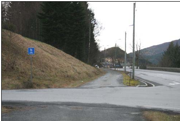
Der er ikkje noko som klart framhevar g/s-traséen i krysningspunktet med Osborgvegen. Uoversiktleg overgang. E39 til høgre i bildet.
