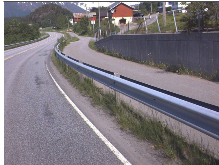
Foto viser situasjonen langs eksisterande g/s-veg.
