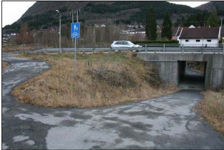
G/s-veg systemet ved undergangen, tatt frå nordsida av E39.
