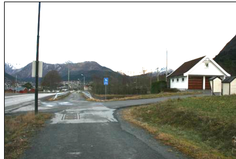
G/s-veg systemet på sørsida av E39, like vest for undergangen. Typisk eksempel på at adkomstveg til bustader kryssar g/s-vegen og munnar ut i E39, utan synleg skille mellom g/s-veg og adkomstveg. Sett mot aust.
