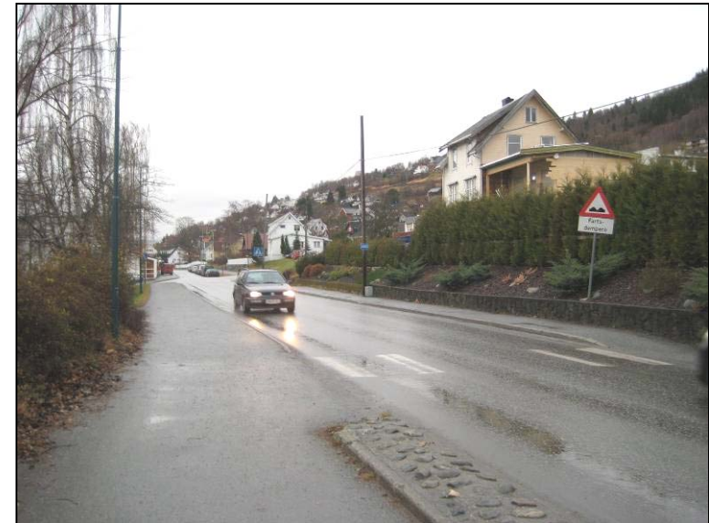
Foto over viser situasjon langs Kårstadvegen.
