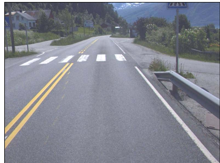
Foto viser situasjonen ved tilknytning til eksisterande g/s-veg.
