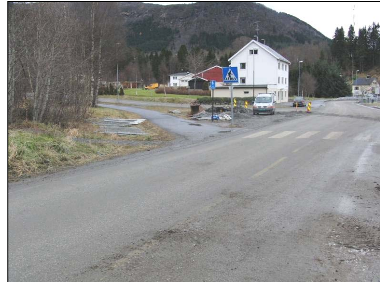
På Dalevegen mot kryss til Mosmarkvegen/Anders Hovdengata/Rossåbrua
