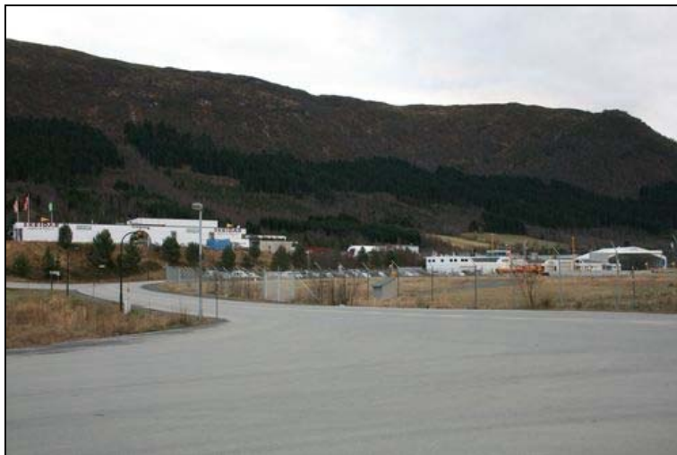
Innkøyring frå Torvmyrane til bensinstasjon og verkstadsområdet (flyplassen bak gjerdet midt i bildet). Stort utflytande asfaltområde, uklart køyremønster. Uklart også for gåande og syklande.
