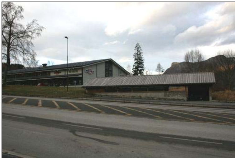
Sett mot nord. Undergangs-overbygget ved busslomma på nordsida av E39. Møbelsenteret i bakkant.
