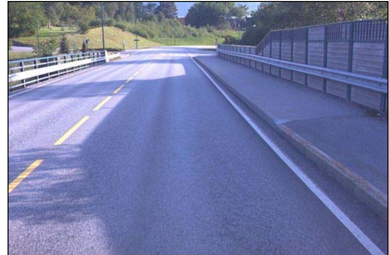
Sett sør-vestover mot sentrum, her er einsidig fortau på brua over Øyraelva og turveg/friområdet.
