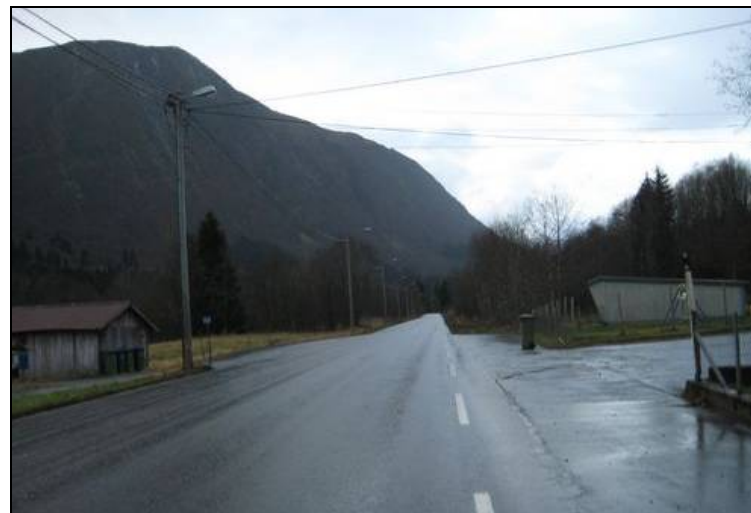
Frå Dalevegen (RV 655 like etter brua ved Brungot) sett nord-vestover mot Ørsta. Spredt bebyggelse og landbruksareal.
