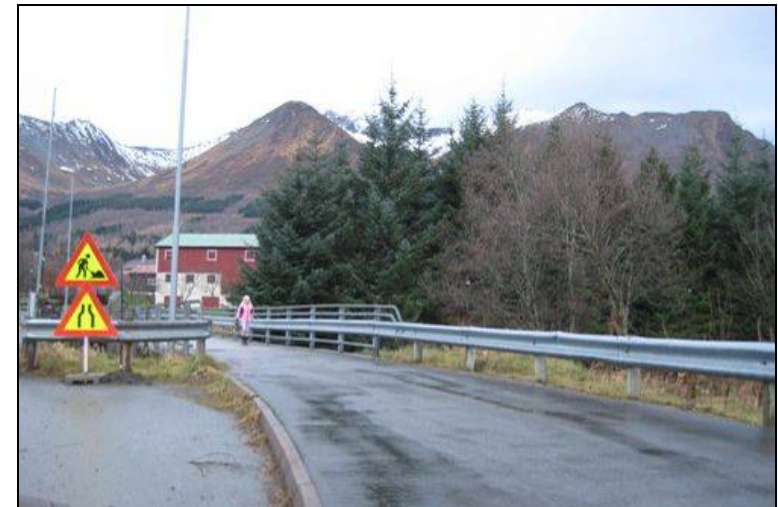
Bildet under: Fortau går over til g/s-veg ved Rossåbrua (over Rossåelva).
