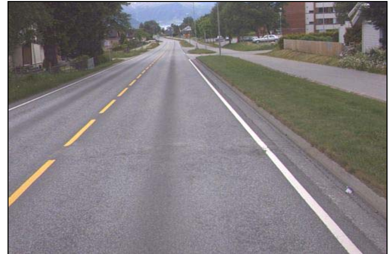
Bildet over: Tettare bebyggelse dess lenger vest ein kjem. Eksisterande g/s-veg held fram på nordsida av fv 45.
