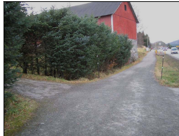
Foto over viser siktproblem på sørsida av E39 og foto under viser manglande gangfelt over E39.
